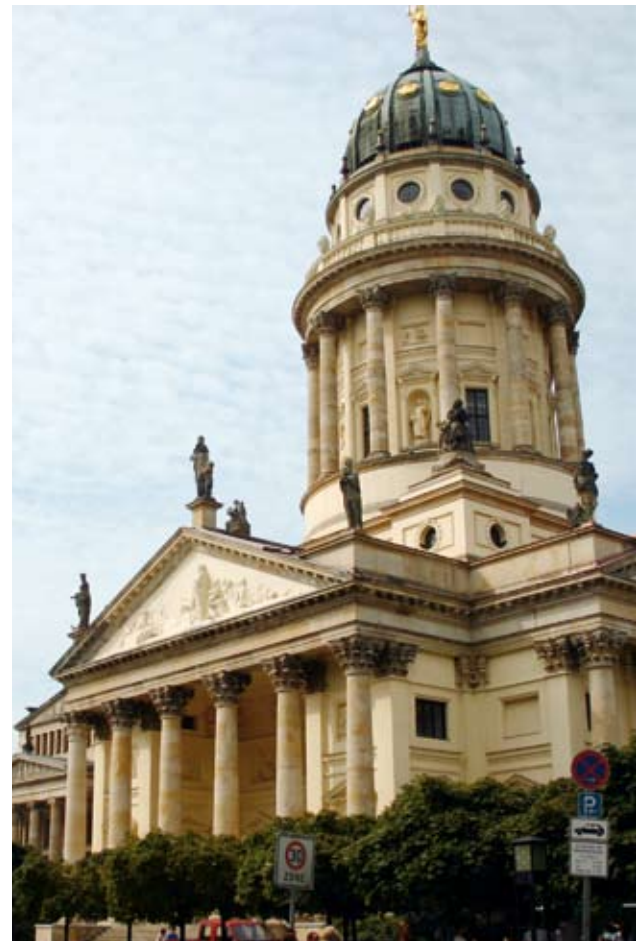
Sanierputze der BASF verhelfen dem Französischen Dom in Berlin zu neuem Glanz.
