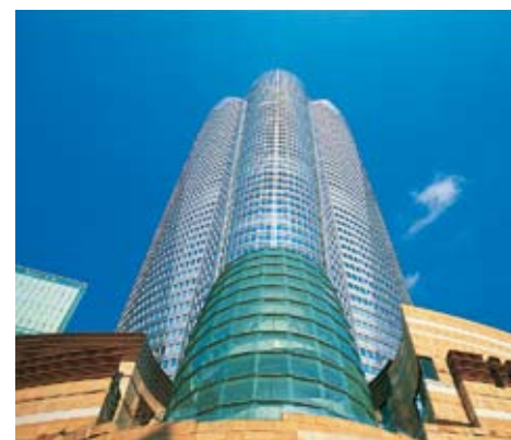
Erst Hunderte von Metern pumpen, dann schnell erhärten – der Roppongi Hills Tower stellte extrem hohe Anforderungen an den Beton.
