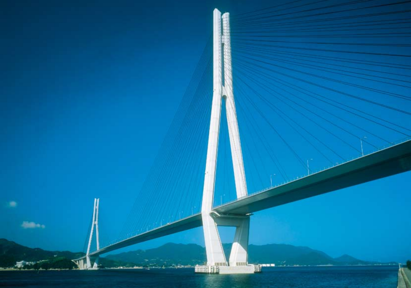
Tatarabashi-Brücke, Japan. Schrägseilbrücke mit einer Spannweite von 890 m und Pylonen aus hochstabilem Stahlbeton.
