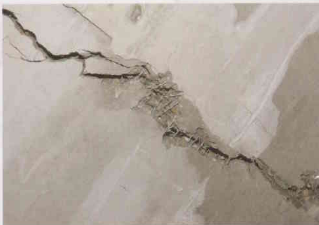
Sättigung der Betonmatrix mit Fasern
