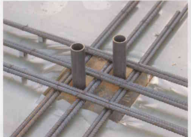
Untere Position von APC-Betonrippenstahl an der Stütze
