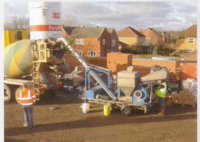
Mechanische Einmischung mit Hilfe eines Einblasgerätes in den Fahrmischer
