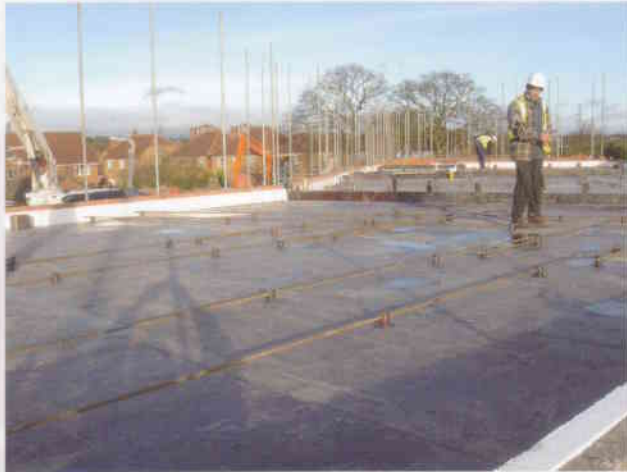
Montage von APC-Bewehrung
