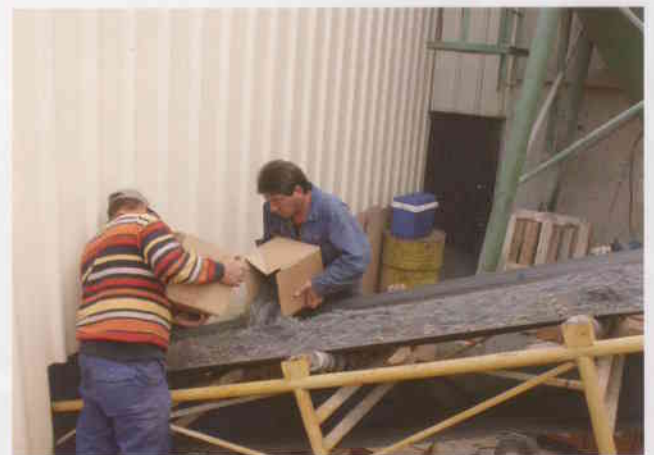
Manuelle Fasereinmischung an der Zuteilungsanlage des Betonwerkes
